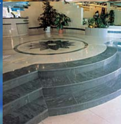
Закругление торца плитки (толщина до 12 мм) по дуге
